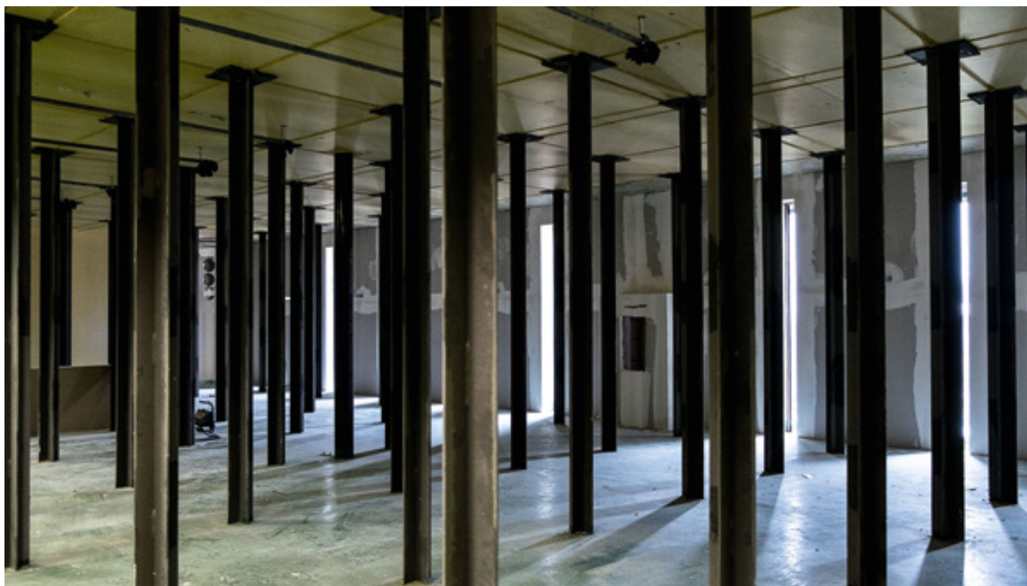
Un étage du silo le 24 avril 2019 débarrassé de son mobilier avant qu'il soit confiné pour le désamiantage. Photographie : Jacqueline Salmon
