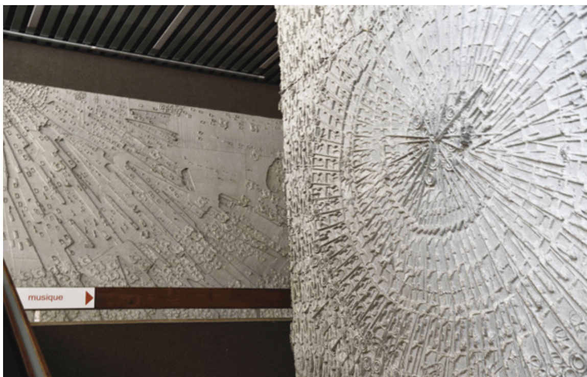
Ci-dessous: Bibliothèque de la Part-Dieu, Lyon. Parements intérieurs en béton estampé des escaliers, 2019. BmL, photographie: Jean-Luc Bouchier.
