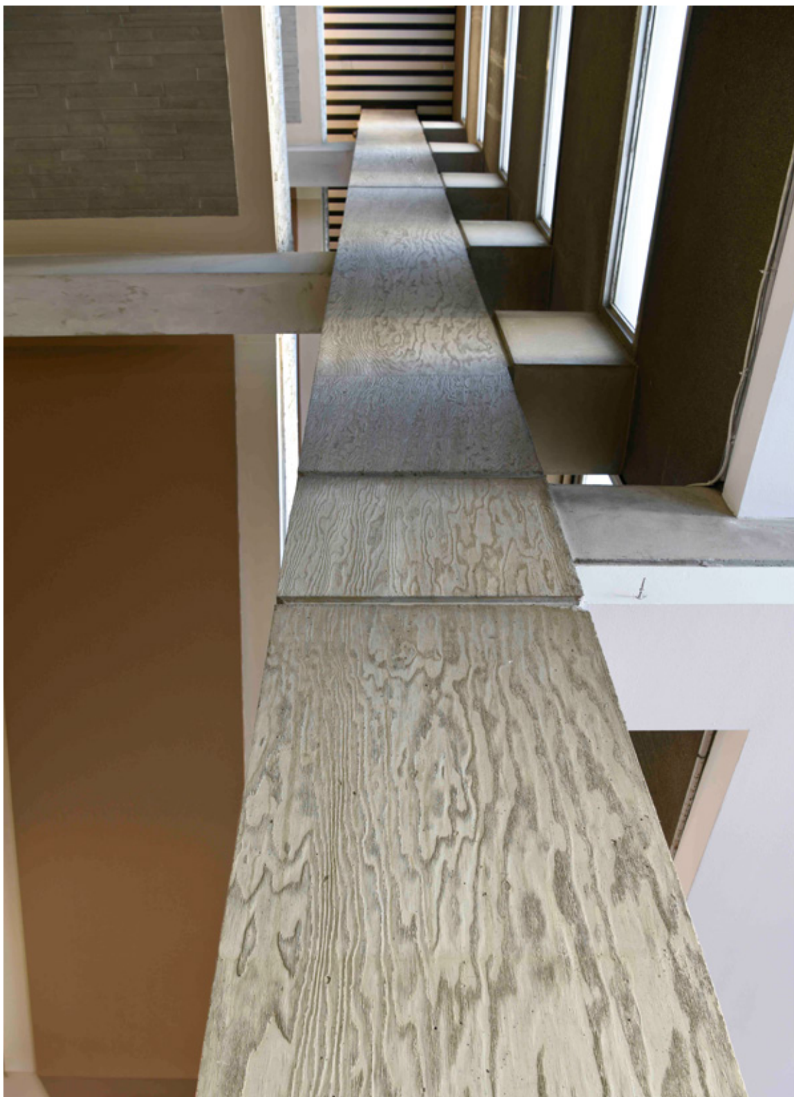
Aspect des piliers intérieurs coulés dans des coffrages revêtus de pin d'Oregon sablé, 2019. BmL, photographie: Jean-Luc Bouchier.
