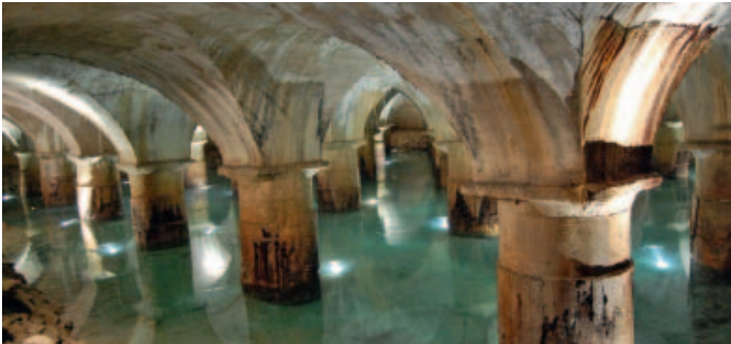
Usine des eaux – les bassins filtrants
