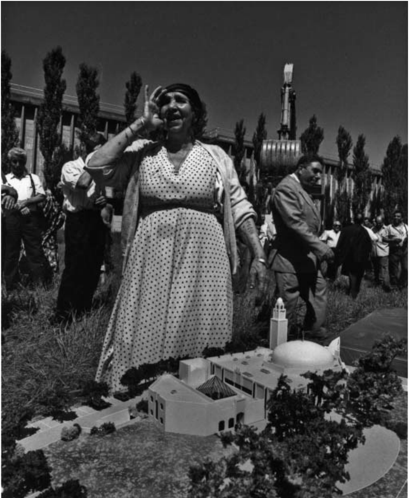
Cérémonie de la pose de la première pierre de la Mosquée de Lyon © BM Lyon - Lyon Figaro - Marcos
