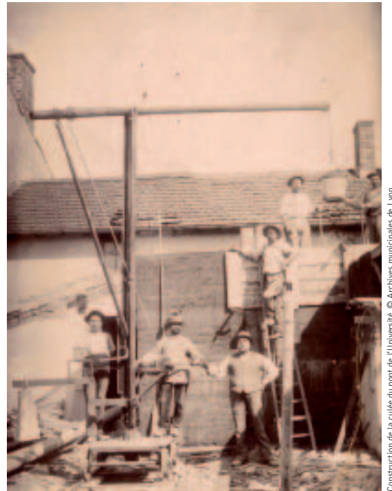
Construction de la culée du pont de l'Université. © Archives municipales de Lyon
